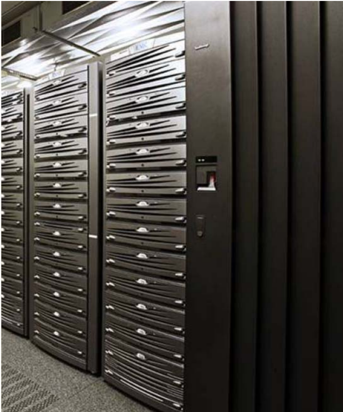
Abb. 14.3.4 Server Farm im Fiducia Rechenzentrum
