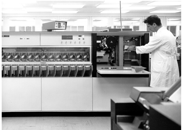
Im Bild oben der Klarschriftleser-Sortierer IBM 1418 für den Anschluß an 1400er Serie-Systeme. (Siehe auch unter E 6.3, „Zeichenerkennung“).
